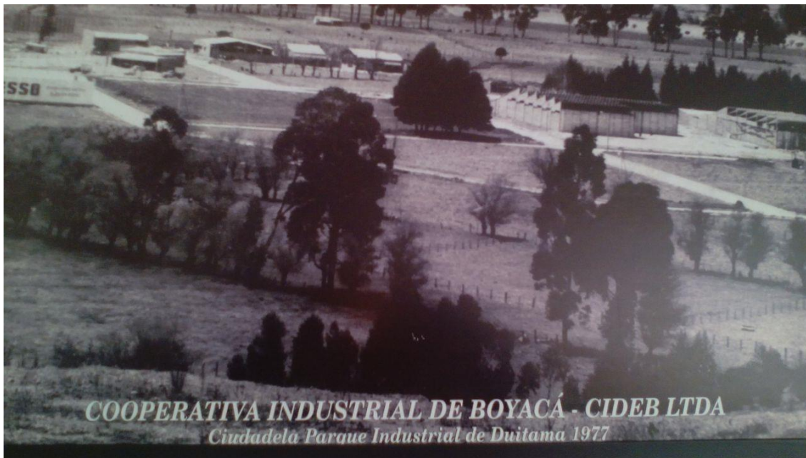
Figura 1. Panorámica del Parque Industrial 1977
