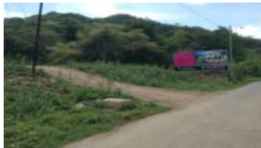
Acceso a condominio en construcción
