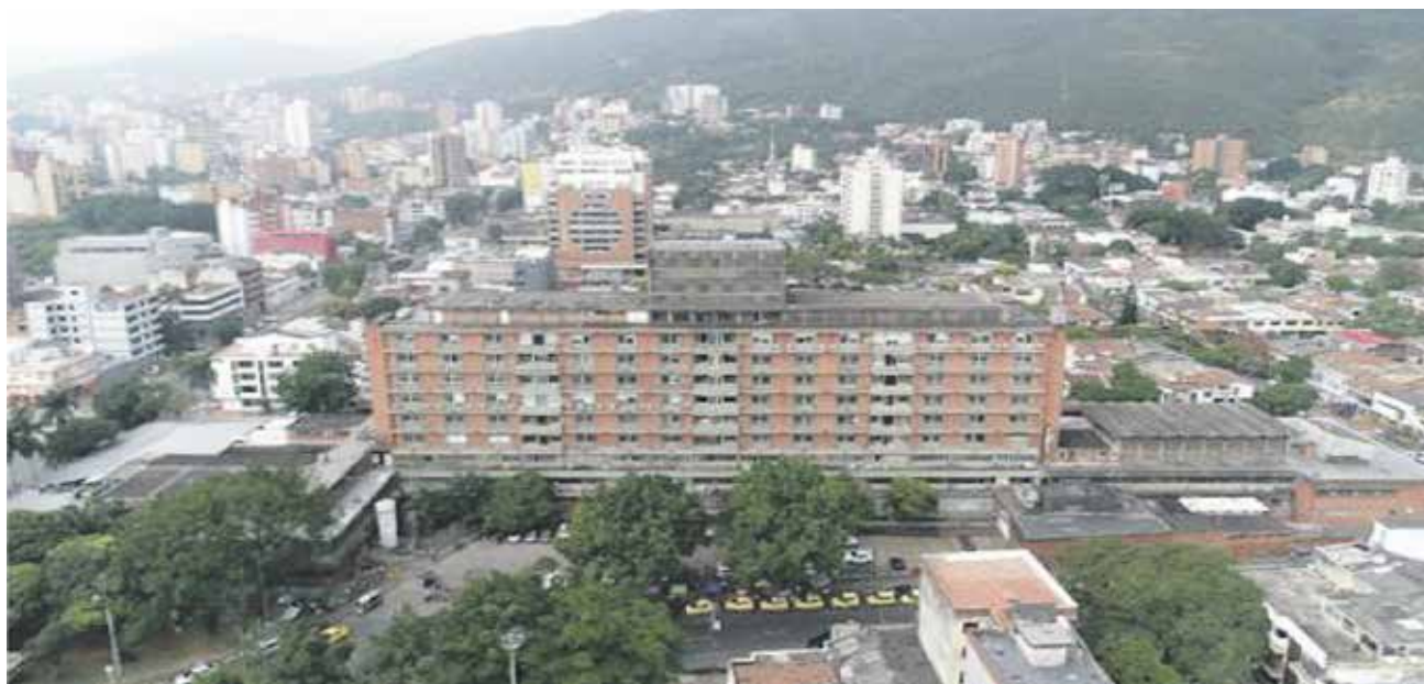
Edificio Benjamín Herrera S. A. S. NIT. 900.276.899-3
