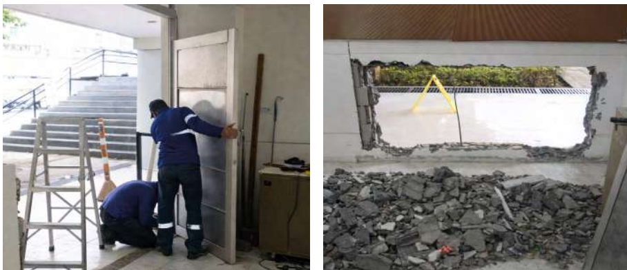
Ilustración 7. Adecuaciones Laboratorio de prototipado Seccional Cali.
