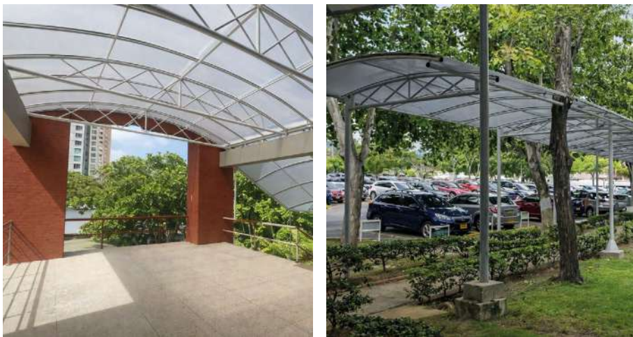
Ilustración 3. Obra para la construcción de senderos peatonales en la Seccional Barranquilla
