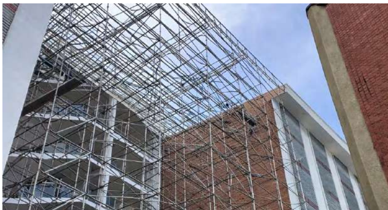
Ilustración 4. Cambio de estructura y laminas en fachada frontal en la Seccional Barranquilla
