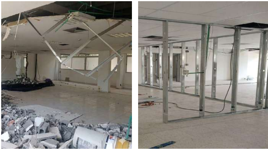
Ilustración 8. Obras de adecuación del Consultorio Jurídico Seccional Cali
