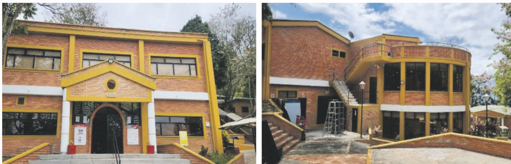
Ilustración 33. Adecuación de la Biblioteca Seccional Socorro
